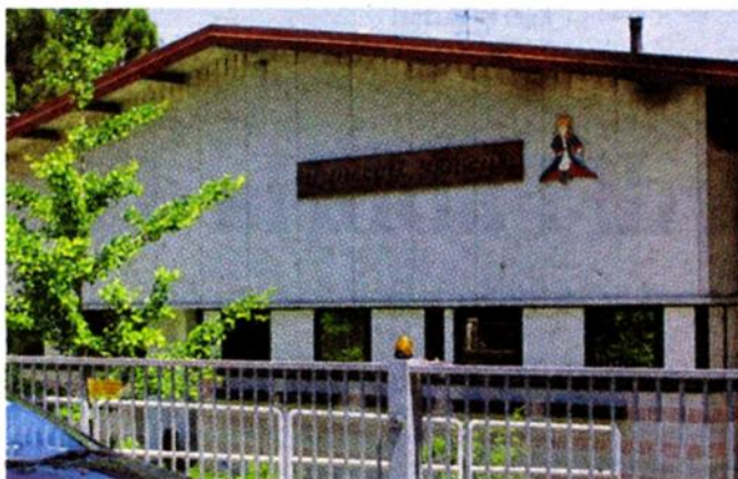
La vecchia sede del Piccolo Principe danneggiata da un incendio
