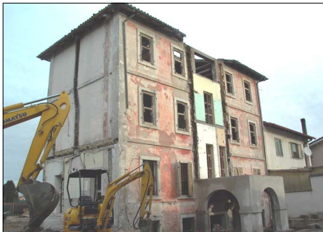
Inizio lavori (vista dal retro).
